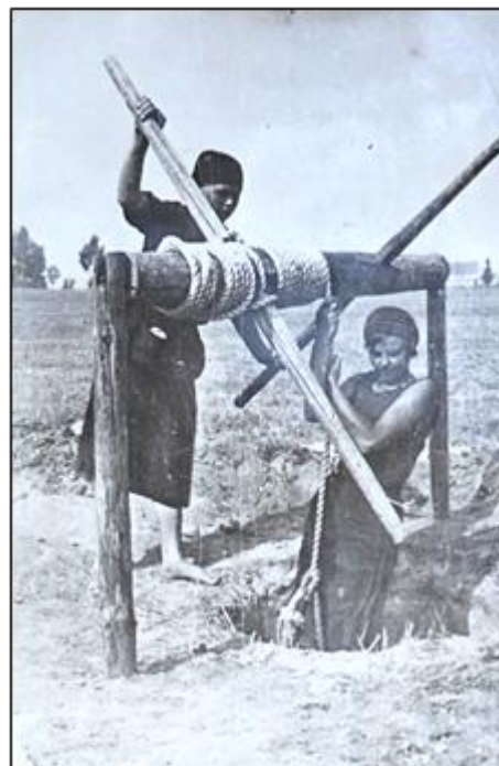
Проходка дудки. Разведке месторождения песков, 1932 г.
