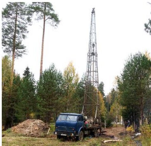
Бурение гидрогеологической скважины, санаторий Оболсуново, 2020 г.
